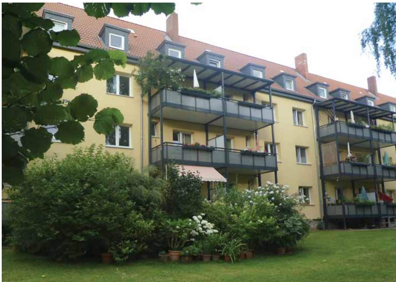
Slika 2: Celovita prenova večstanovanjske stavbe, Vir: Neva Jejčič
