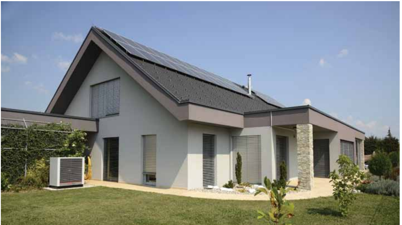
Slika 1: Sodoben način ogrevanja in priprava sanitarne vode s toplotno črpalko, ki jo napaja sončna elektrarna, Vir: Kronoterm
